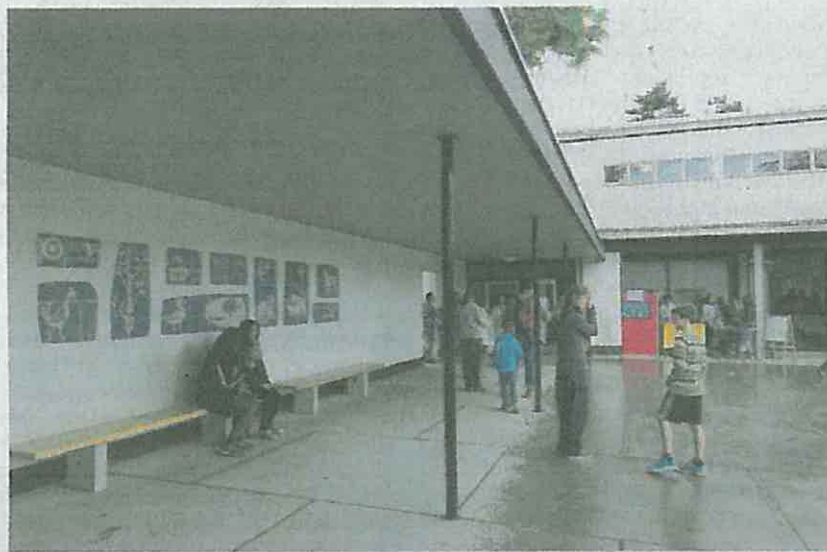
Der Eingangsbereich zur Aula und zur Gemeindebibliothek.
